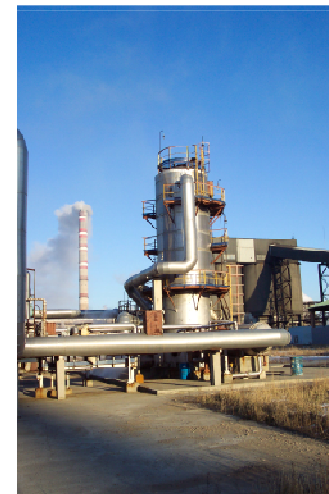
Реактор селективного окисления сероводорода на Омском НПЗ (разработка ИК СО РАН)
