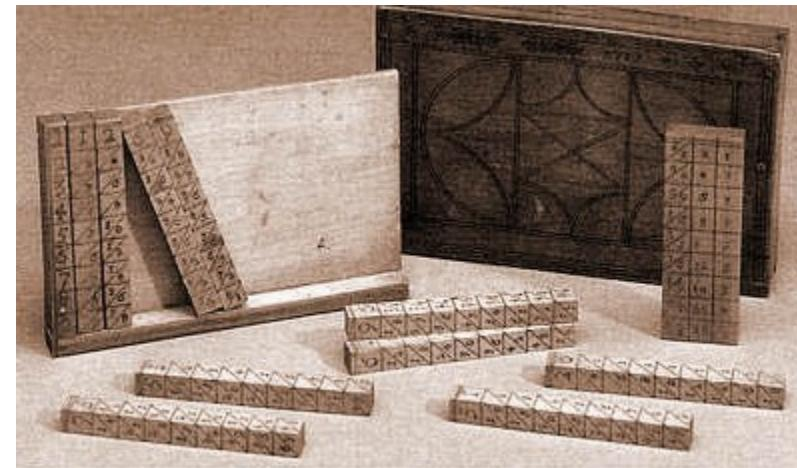
Таблицы Непера, расчет которых требовал очень много времени, были позже "встроены" в удобное устройство, чрезвычайно ускоряющее процесс вычисления - логарифмическая линейка. Непер же придумал в 1617 году (год его смерти) другой - не логарифмический- способ перемножения чисел..
